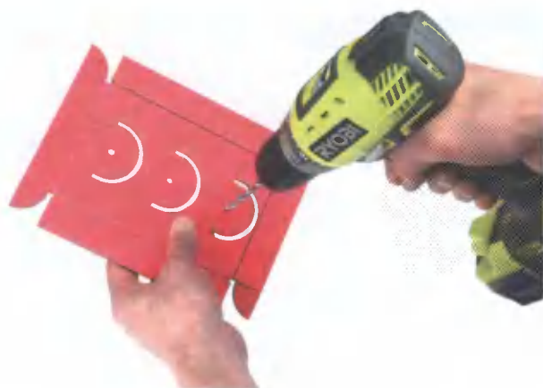
Рис. 2.17. Сверление отверстий под светодиоды
